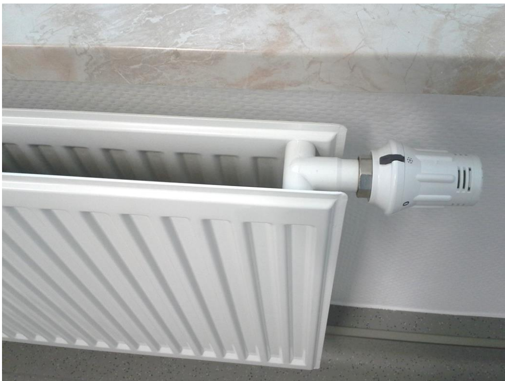
Abb. 1) Leicht zu reinigender Heizkörper ohne Konvektoren © A.-S. Schinzel
