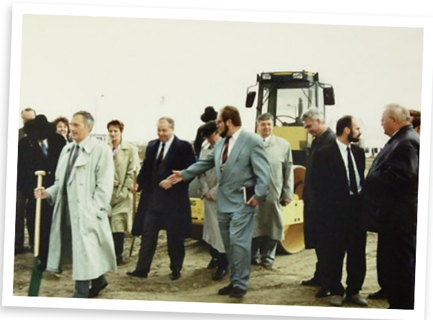
Spatenstich für die Dienststelle in der Braunstraße
